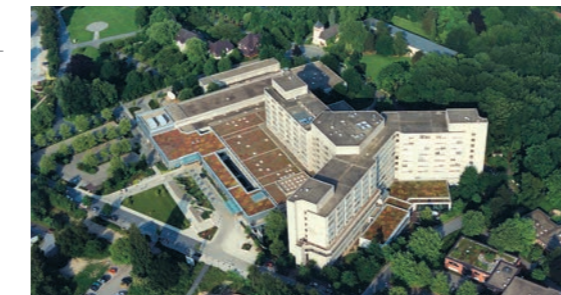
Das Alfred Krupp Krankenhaus in Essen führt die Tradition der 1870 gegründeten Krupp'schen Krankenanstalten fort.
